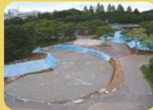
基礎工(撮影9月1日)。青いシートで養生中
