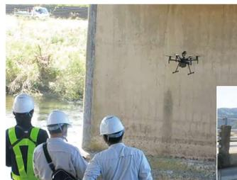
健全度Ⅲの橋梁で、補修対象が桁端部、桁下全体にあるため、ドローン点検と橋梁点検車を併用。
