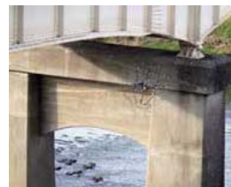
実橋梁での点検試行
