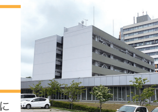
工学部管理棟
