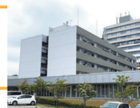
工学部管理棟
