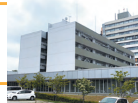
工学部管理棟
