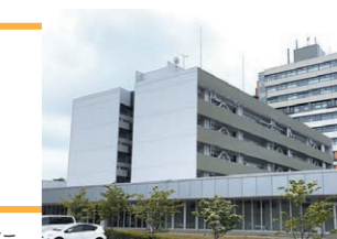
工学部管理棟
